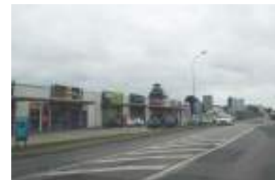
Succession de ZAE le long de la D906 (entrée Sud de l'agglomération mâconnaise).
