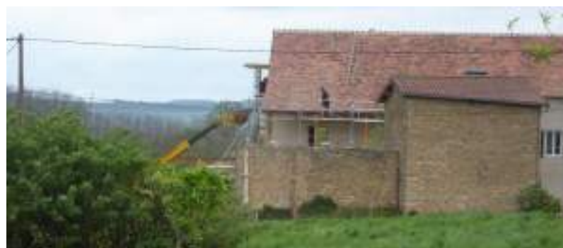
Bâti en cours de réhabilitation.
