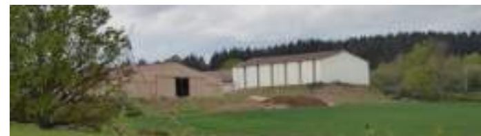
Bâtiment agricole mal intégré dans le paysage.
