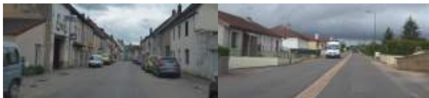
Traversées non qualitatives, n'invitant pas à l'arrêt, ni au ralentissement de l'automobiliste, et manquant d'aménagement sécuritaire pour les piétons (St-Oyen (Montbellet), Joncy, Dompierre-les-Ormes).
